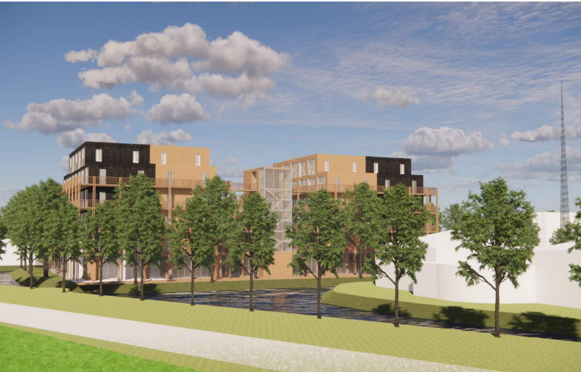
Voorgevel vanaf het zuid-westen
