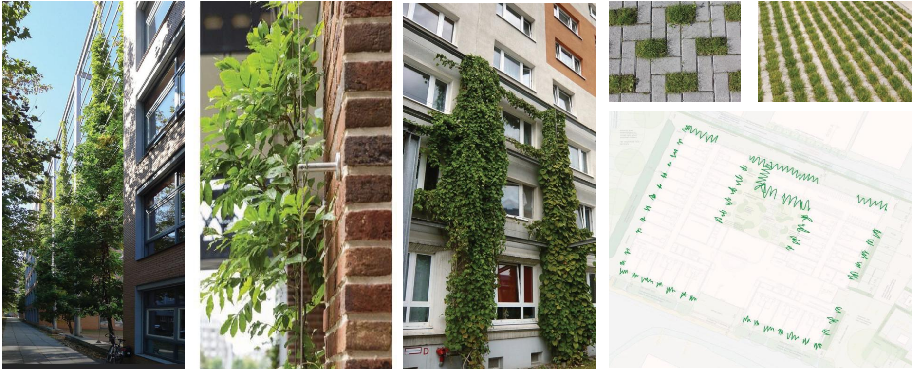
Rankende klimplanten tegen gevel opleiden met spandraden, vergroenen bestrating rondom gebouwplint met grastegel of grasstenen
